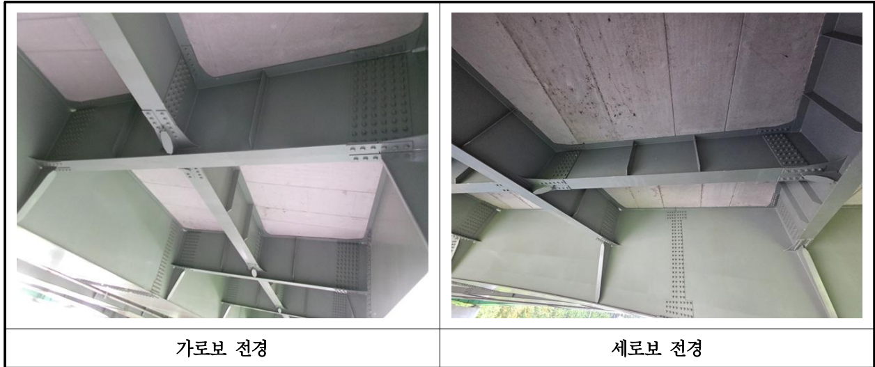
【사진 1.3.6】 가로보 및 세로보 전경
