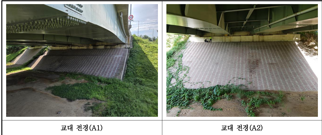
【사진 1.3.8】 교대 전경
