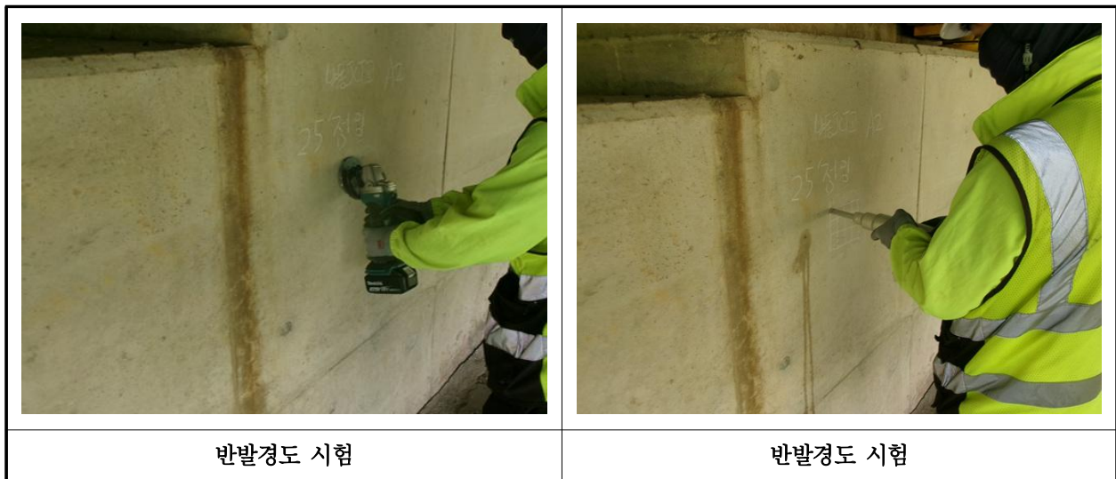
【사진 1.4.2】 반발경도시험 현장사진
