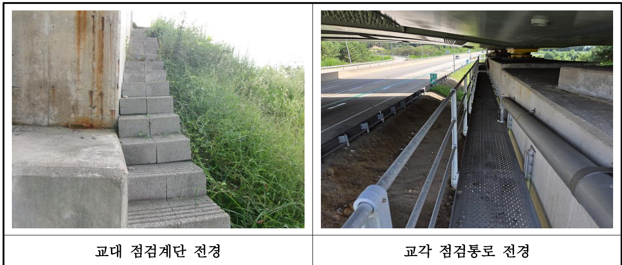
【사진 1.3.26】 교량 점검시설 전경
