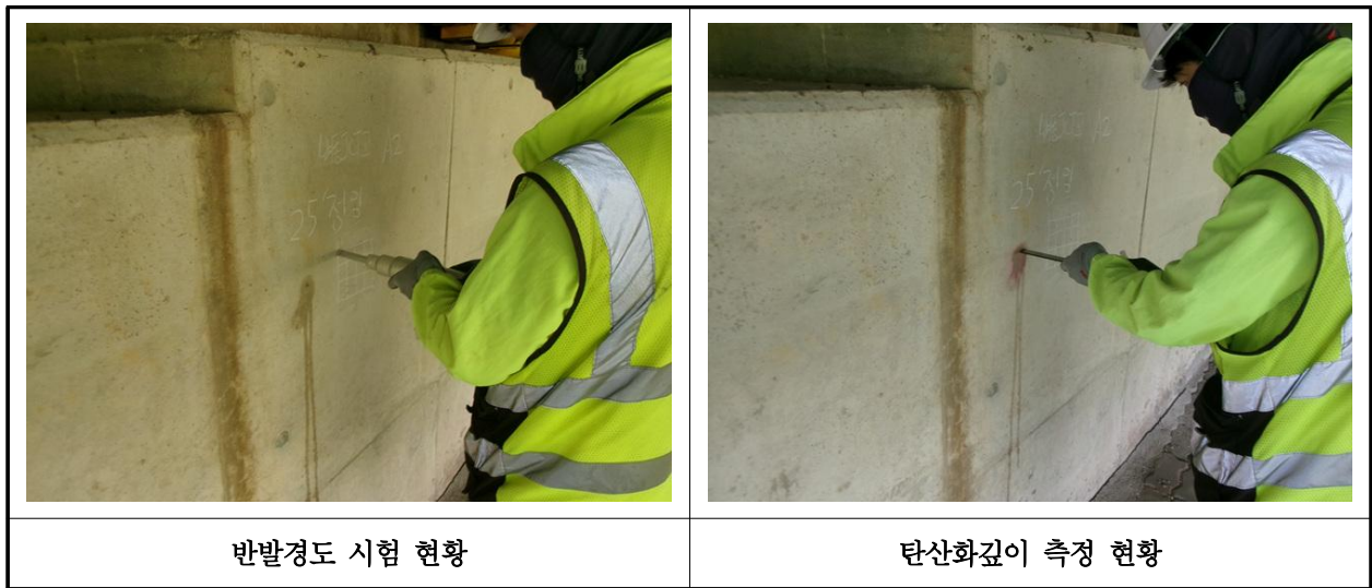
【사진 1.4.1】 콘크리트 내구성조사 현황
