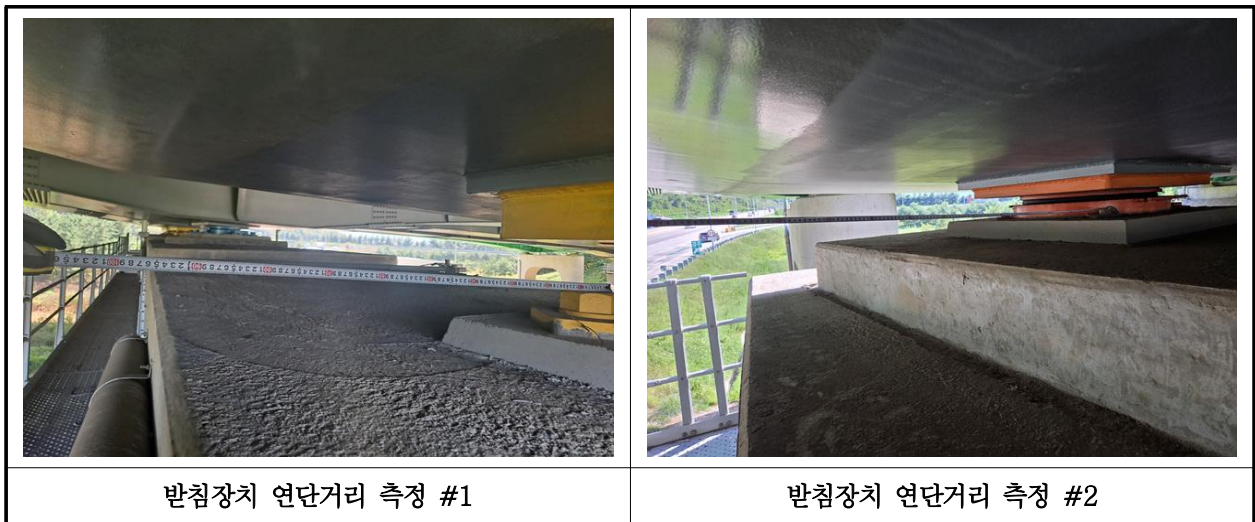
【사진 1.3.15】 교량받침장치 연단거리측정
