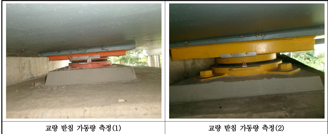
【사진 1.3.16】 교량받침 이동량 측정
