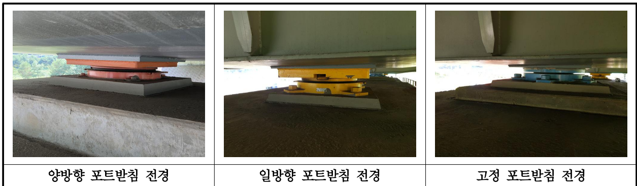
【사진 1.3.13】 교량받침 전경
