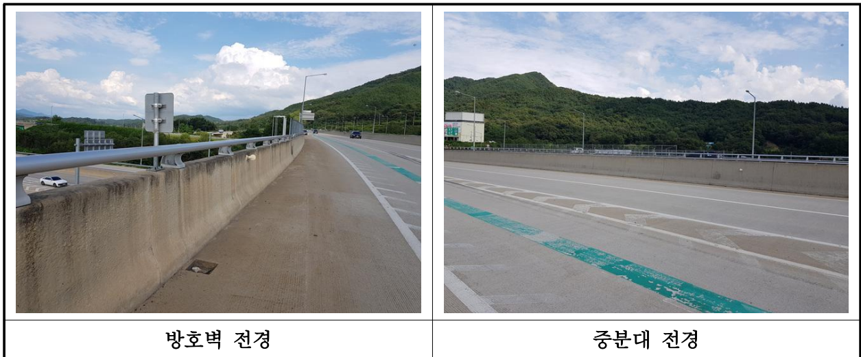
【사진 1.3.24】 방호벽 및 중분대 전경
