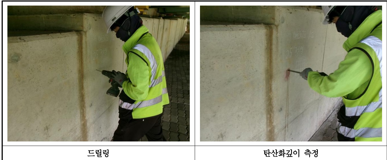
【사진 1.4.3】 탄산화 깊이 측정 현장사진
