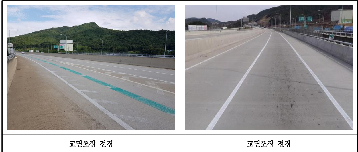
【사진 1.3.20】 교면포장 전경
