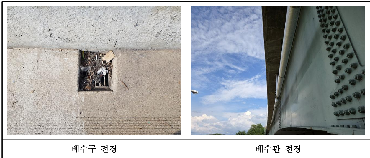
【사진 1.3.22】 배수시설 전경
