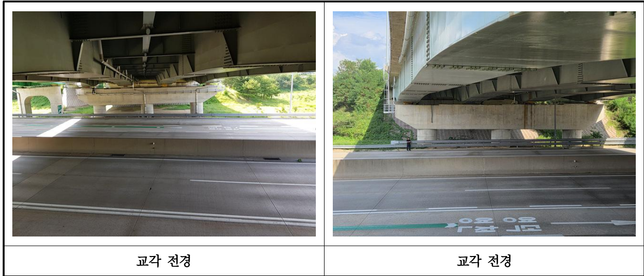
【사진 1.3.10】 교각 전경
